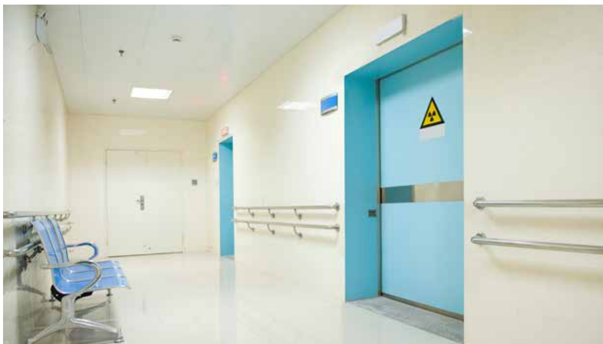
drzwi GAMMA, ościeżnica stała metalowa
