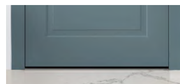
Skrót „rekuperacyjny” (szczelina), wys. od podłogi 14 / 16 mm
